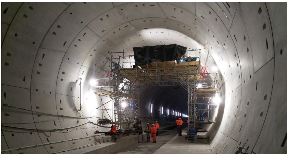
Abbildung 1: Tunnelröhre mit fahrbarem Gerüst für die manuelle Prüfung
